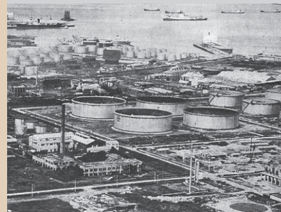
▲ 旧三菱系の企業群が中心となって進出した四日市の第一コンビナート (出典「四日市市史」〔四日市市〕)
