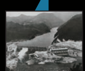
▲ 鹿瀬ダム (東北電力提供)
