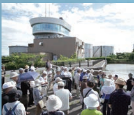
▲山の下間門排水機場
