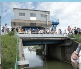
▲津島屋間門排水機場
