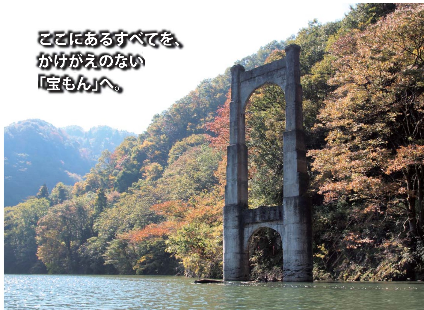
「橋脚だけになった昭和橋の名残り」かつてここから石灰石が採掘され、昭和電工(株)鹿瀬工場へ運搬された。
