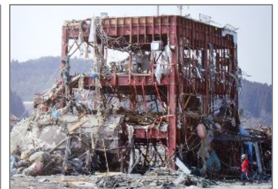
大津波にのみこまれ、骨組みだけになった宮城県南三陸町の防災対策庁舎
